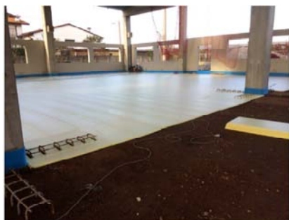
Posa isolante per impianto di riscaldamento
