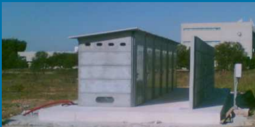
Esempio di deposito gas con muro di protezione
