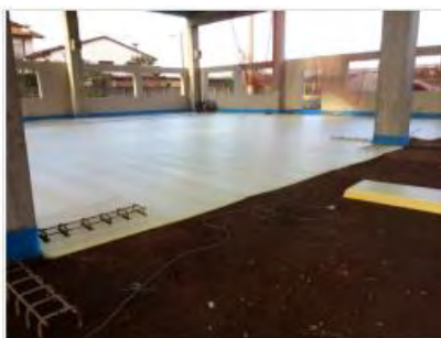
Posa isolante per impianto di riscaldamento
